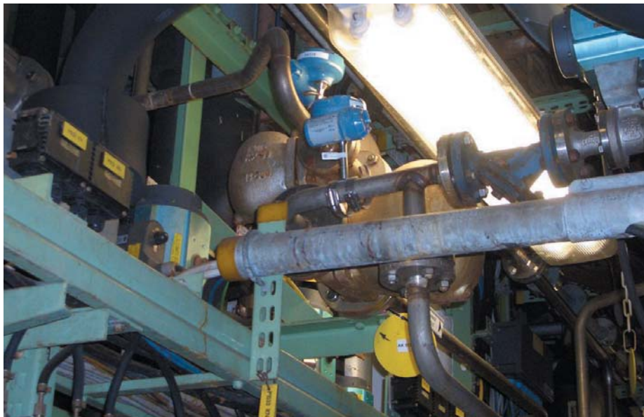
РИС. 4. ▲ В зависимости от точной классификации помещения, беспроводные преобразователи могут устанавливаться в потенциально опасных зонах без какой-либо дополнительной защиты
