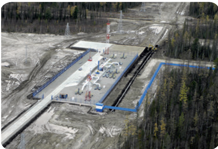
Магистральный нефтепровод Пурпе – Саянск.
