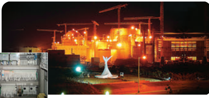
Рис. 8. АЭС «Куданкулам» (Индия) и контроллер FASTWEL I/O СРМ703 в составе оборудования одной из систем контроля и управления установки отверждения жидких радиоактивных отходов.
