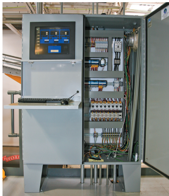
РИС. 2. ▼ Готовые к работе почти сразу после установки встраиваемые НМИ отличаются высокой надежностью и компактными форм-факторами, что снижает общие затраты на их внедрение. Изображение предоставлено компанией AutomationDirect
