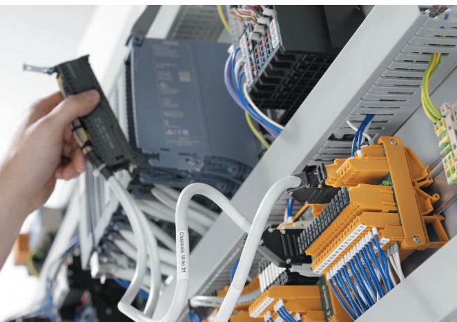
РИС. 1. ▼ Подключение интерфейсного модуля к системе управления
