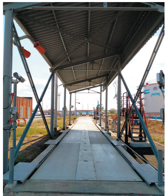
РИС. 2. ▼ Пример расположения камер, направленных внутрь весов
