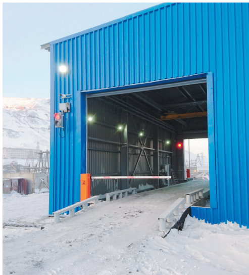
РИС. 3. ▲ Пример установки светофоров и табло в составе АПК «Автомаршал.Весовая»
