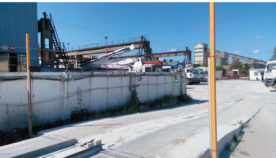
РИС. 4. ▼ Пример использования многолучевых ИК-барьеров: расположение по краю весов
