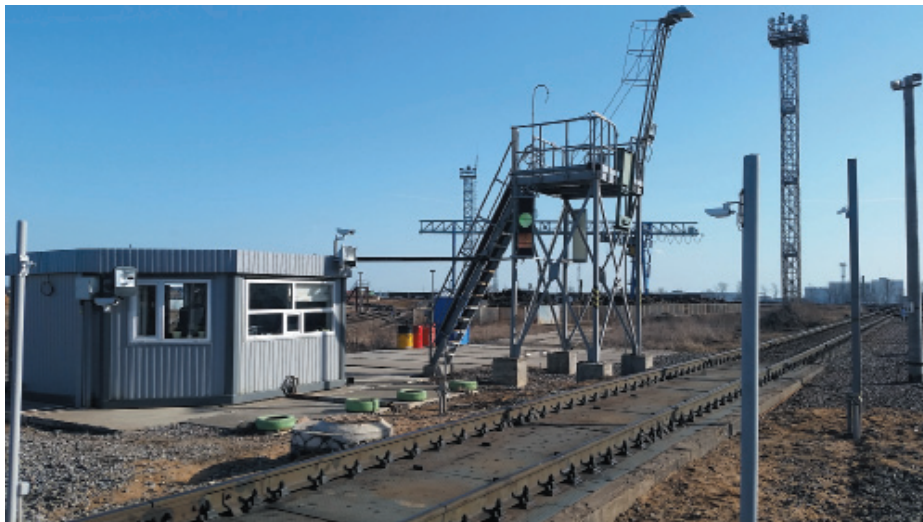
РИС. 1. ▼ Вагонный весовой КПП перед участком выгрузки сырья на металлургическом заводе
