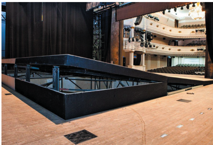
РИС. 4. ► Подъемный механизм сцены
