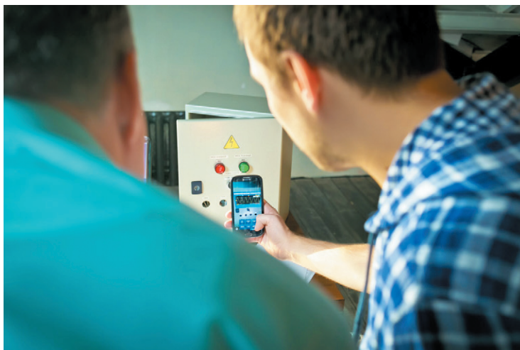
РИС. 12. ► Демонстрация с помощью AR-технологии размещения деталей внутри металлического корпуса изделия для изготовления АВР на основании электромонтажной схемы
