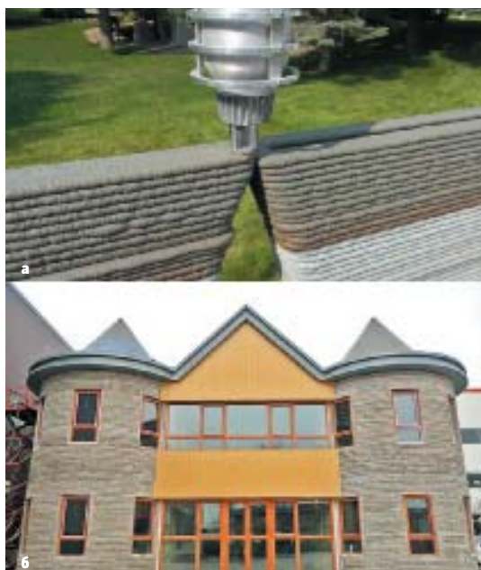
РИС. 9. ▼ Процесс печати виллы: а) 3D-принтер; б) готовый результат
