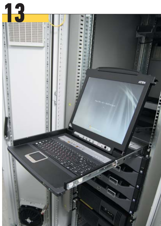
Переключатель KVM Aten системы усовершенствованного управления производства олефинов ЭП-360.
