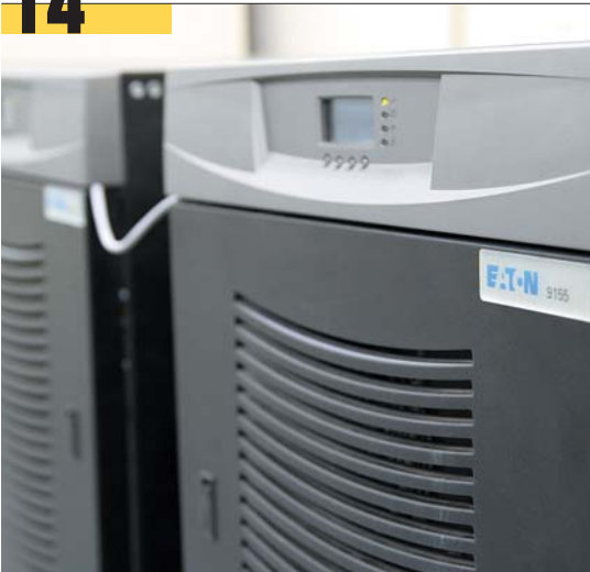
Безопасность бесперебойного питания ИТ-инфраструктуры и оборудования АСУ ТП обеспечивается ИБП от Eaton.
