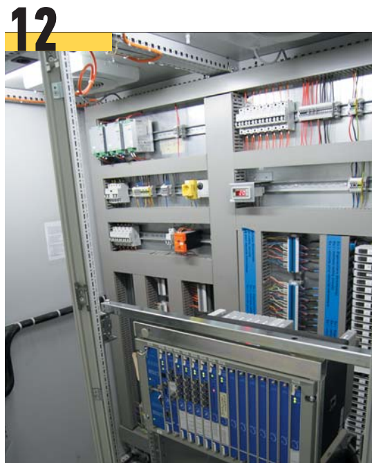
Система Bentley Nevada 3500 обеспечивает мониторинг и защиту роторного оборудования в режиме реального времени. В данном случае – осуществляет вибромониторинг насосов установок подготовки продуктов пиролиза и первичного разделения пирогаза.
