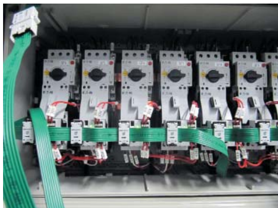
РИС. 6. ▼ Система SmartWire-DT экономит место и увеличивает функциональность оборудования
