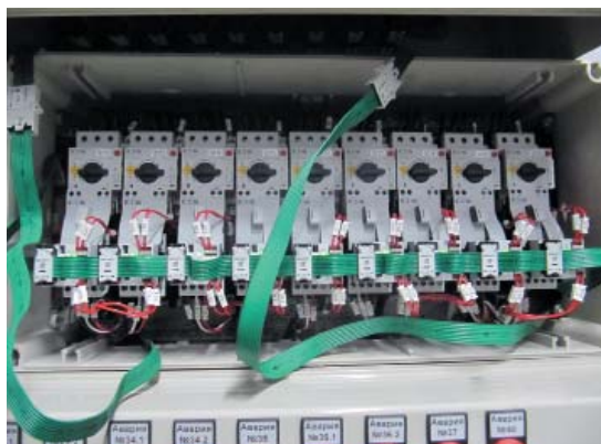
РИС. 5. ▼ SmartWire-DT от Eaton объединяет компоненты автоматизации в единую сеть
