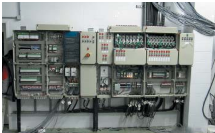
РИС. 4. ► Коммуникационная система Eaton SmartWire-DT на заводе «ДАМАТЕ», г. Пенза
