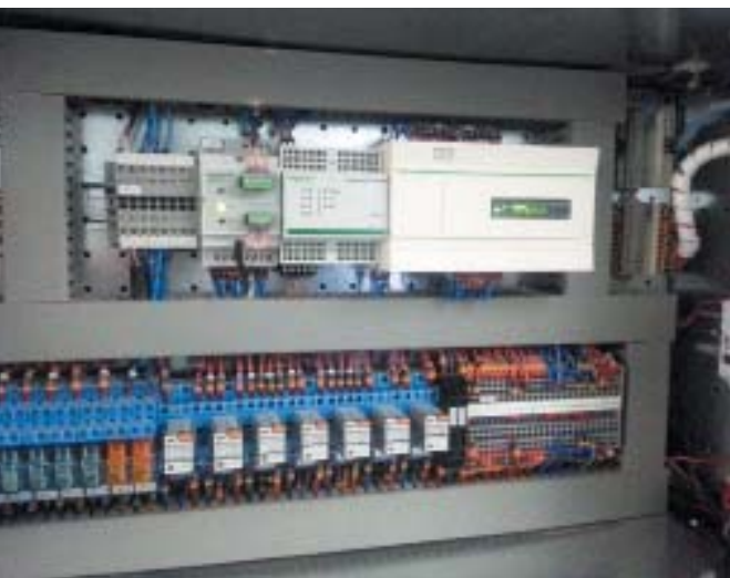
РИС. 4. ▼ Система «Умный щит» изнутри
