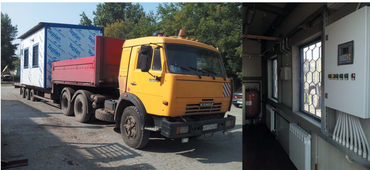
РИС. 3. ▼ Модульная необслуживаемая котельная на базе новой системы автоматизации
