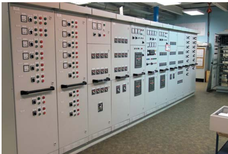
◀ ГРЩ судна «Спасатель Карев»
