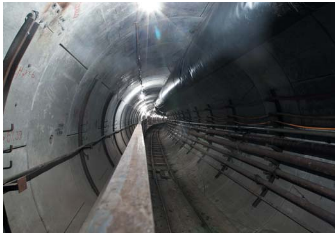
РИС. 1. ▼ Главный канализационный коллектор
