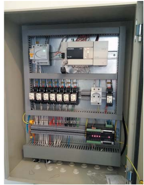
РИС. 2. ▲ Силовой шкаф (а) и станция управления (б)
