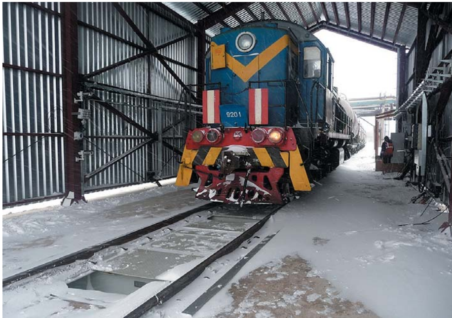
РИС. 4. ▲ Участок коммерческого учета на предприятии ОАО АНК «Башнефть» (на вертикальной балке навеса видны смонтированные телекамеры и осветитель)
