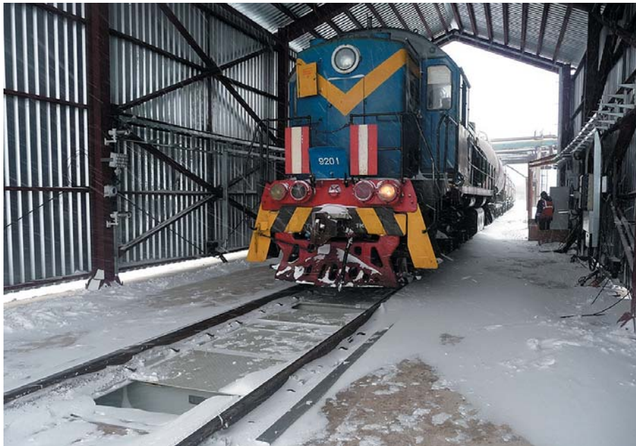
РИС. 4. ▲ Участок коммерческого учета на предприятии ОАО АНК «Башнефть» (на вертикальной балке навеса видны смонтированные телекамеры и осветитель)
